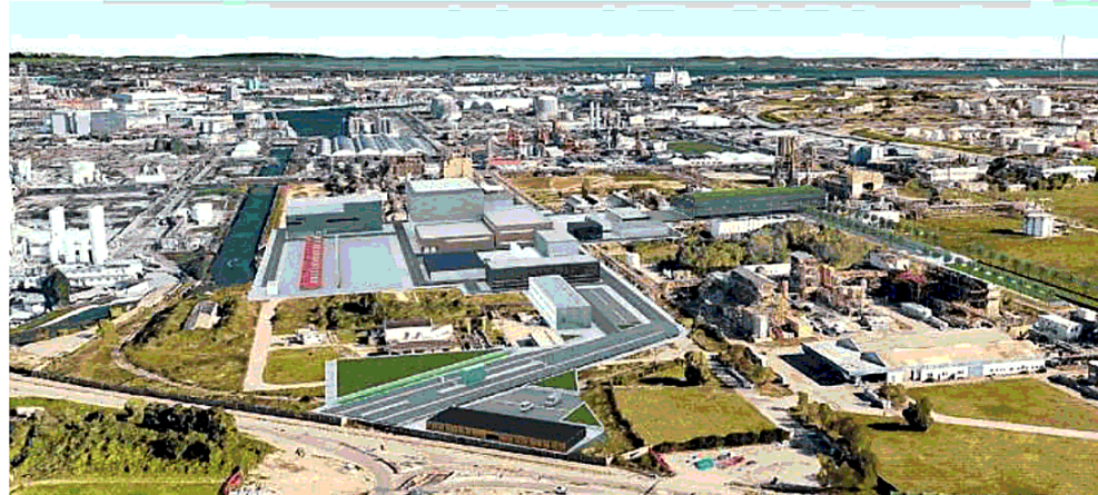
AREA E PROGETTO I terreni nel nuovo Petrolchimico individuati da Comune e Regione per insediare l'esperimento europeo sul DTT per la fusione nucleare pulita
