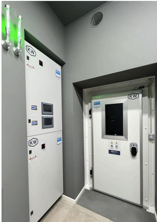
Le celle climatiche utilizzate per conservare la collezione di negativi del KHI © Kunsthistorisches Institut in Florenz – Max-Planck-Institut
