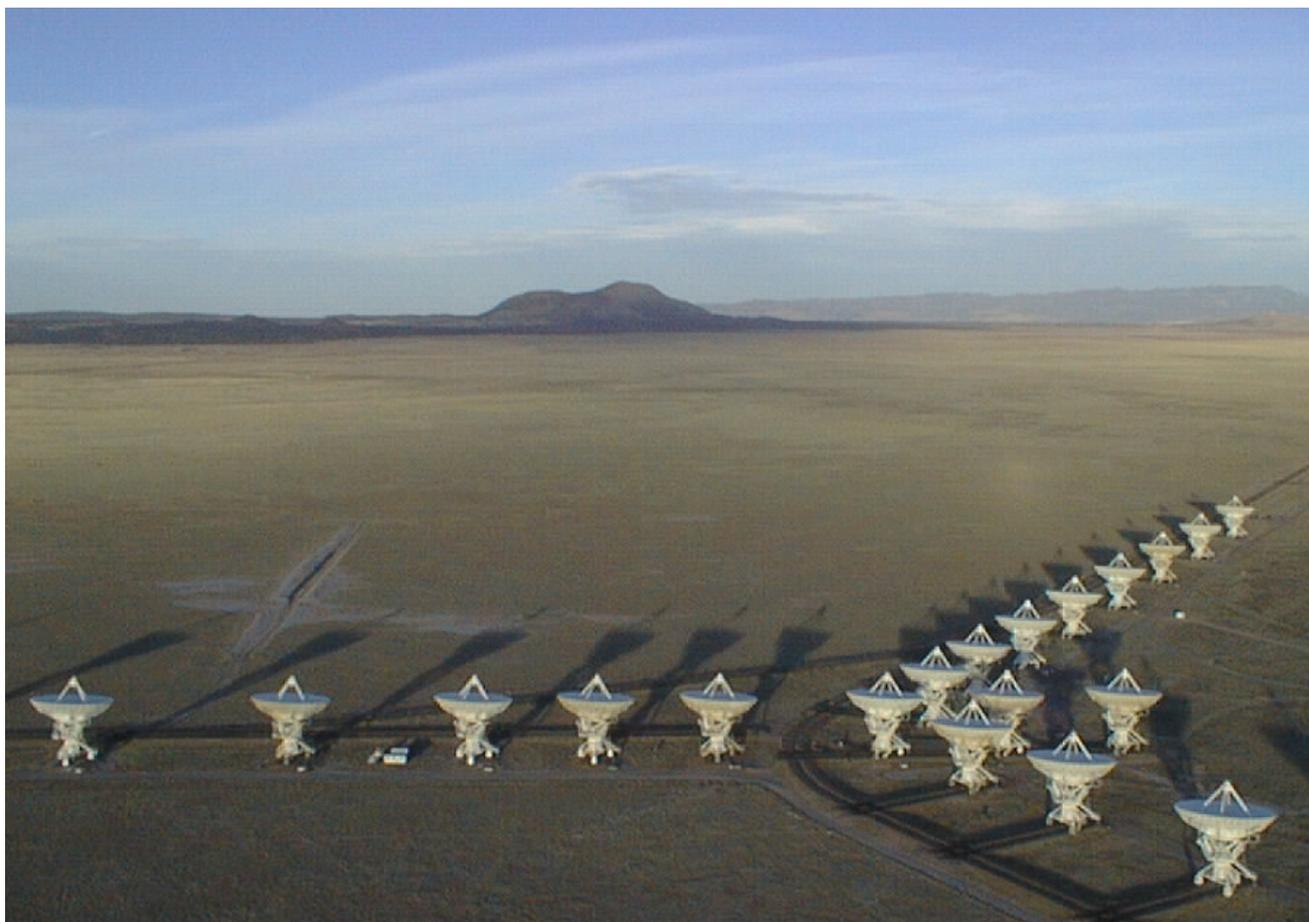
Avendo a disposizione "un po' di deserto" si possono realizzare radiotelescopi del diametro di decine di chilometri che hanno una risoluzione di alcuni primi d'arco.
