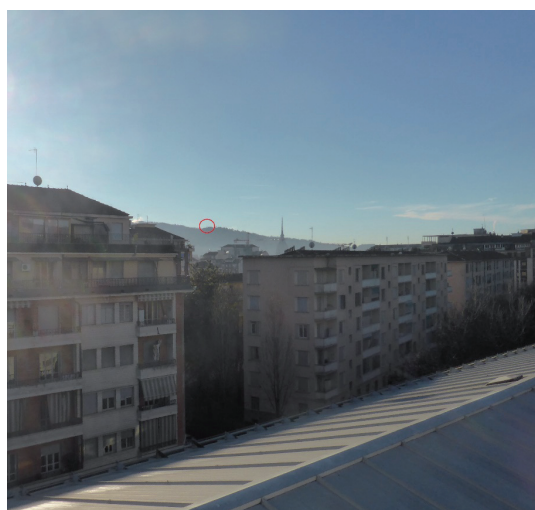
Fig. 1 Sito di dorsale HPWNet, cerchiato in rosso, visto dal tetto di una delle scuole coinvolte
