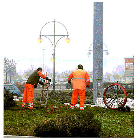
Operai al lavoro in un cantiere per la fibra ottica
