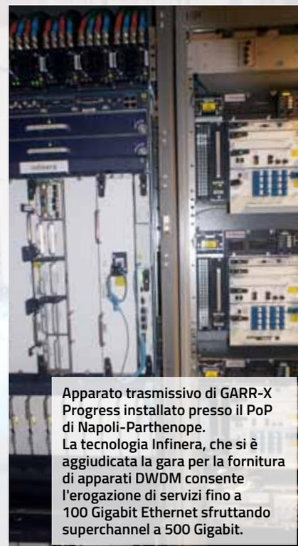
Apparato trasmissivo di GARR-X Progress installato presso il PoP di Napoli-Parthenope. La tecnologia Infinera, che si è aggiudicata la gara per la fornitura di apparati DWDM consente l'erogazione di servizi fino a 100 Gigabit Ethernet sfruttando superchannel a 500 Gigabit.
