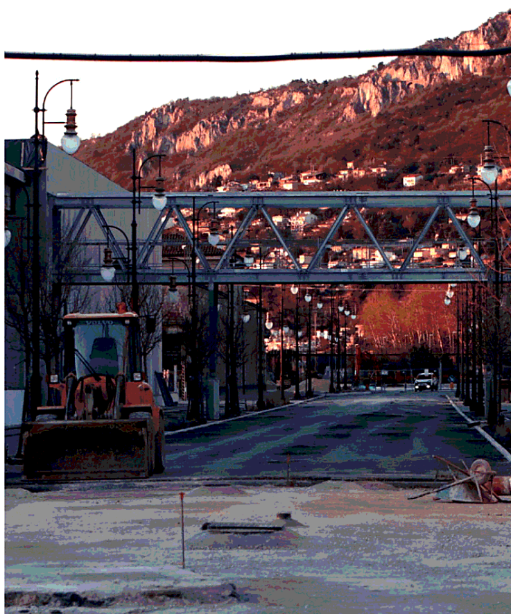
Lavori in corso: diventerà "vetrato" il ponte tra i Magazzini 27 e 28, paga il Comune
