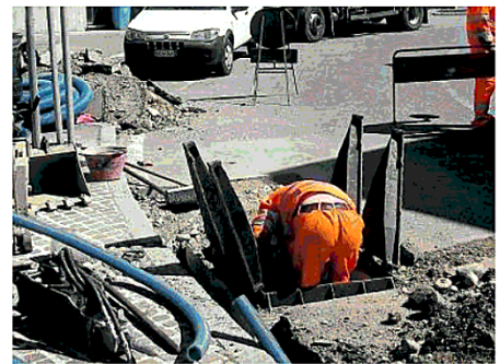
Lavori in corso per la rete internet
