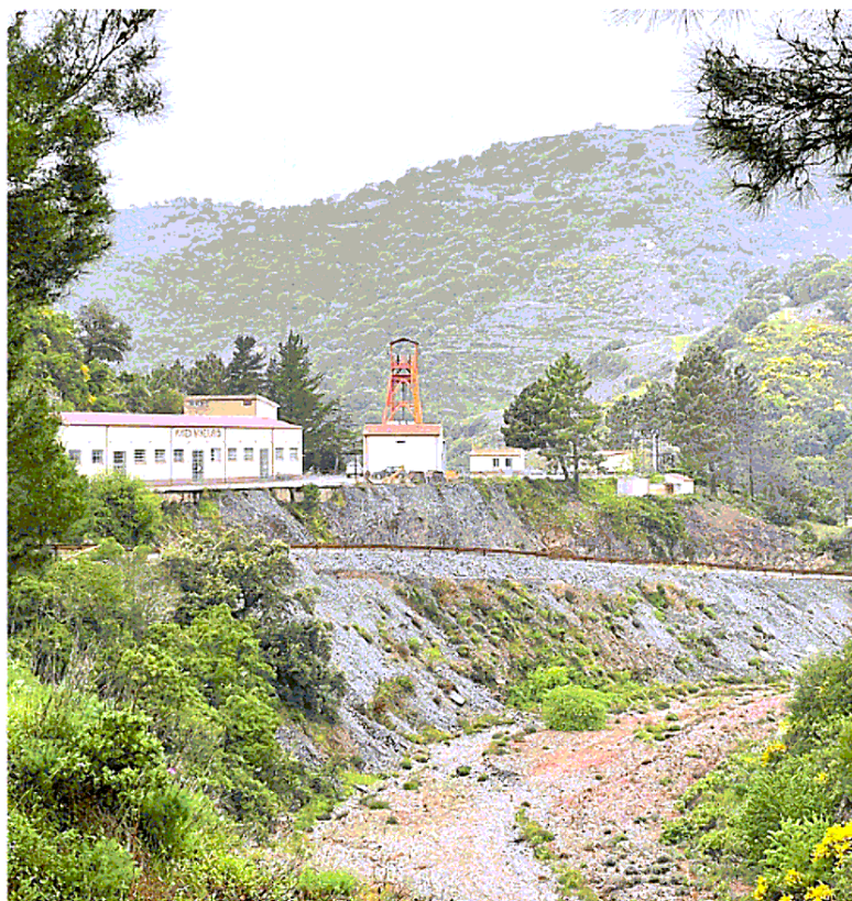
La zona della vecchia miniera di Sos Enattos: si prevede un potenziamento delle infrastrutture per favorire il progetto Einstein telescope
